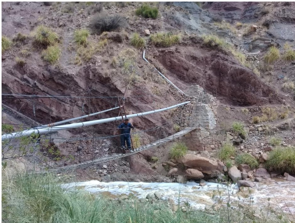
Bewässerungskanal für 3 Dörfer: teilweise Tarapaya, Aroifilia, Tambo Pata Empfang des Wassers einer entfernten Quelle. Eine großartige Arbeit mit 100% Ergebnissen
